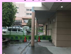
広場側フェンス
