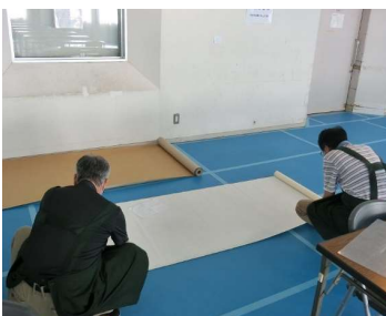
レクホールの壁紙補修中
